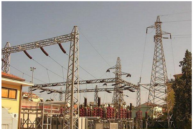
Una sottostazione elettrica ferroviaria con relativi tralicci.
